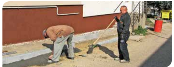
Záverečné stavebné práce pred vynoveným obecným úradom.
