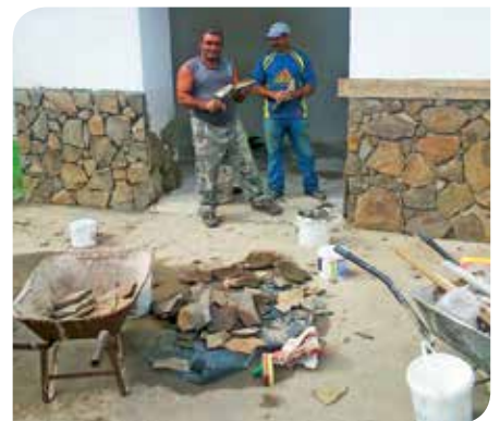
Autobusovú zastávku zrekonštruovali pracovníci menších obecných služieb
